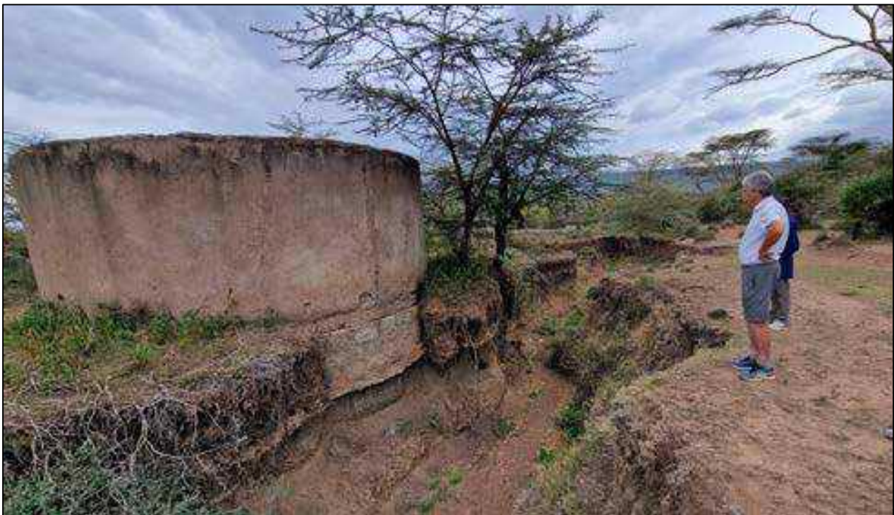
Deze tank zorgt door zijn hoge standplaats voor extra drukopbouw. Zonnepanelen zorgen voor de aandrijving van extra pompen.
