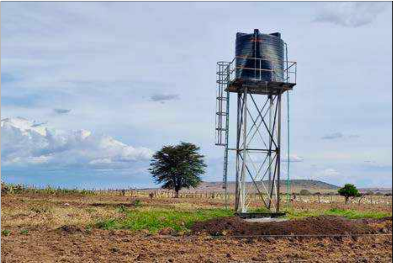
Deze tank zorgt door zijn hoge standplaats voor extra drukopbouw. Zonnepanelen zorgen voor de aandrijving van extra pompen.
