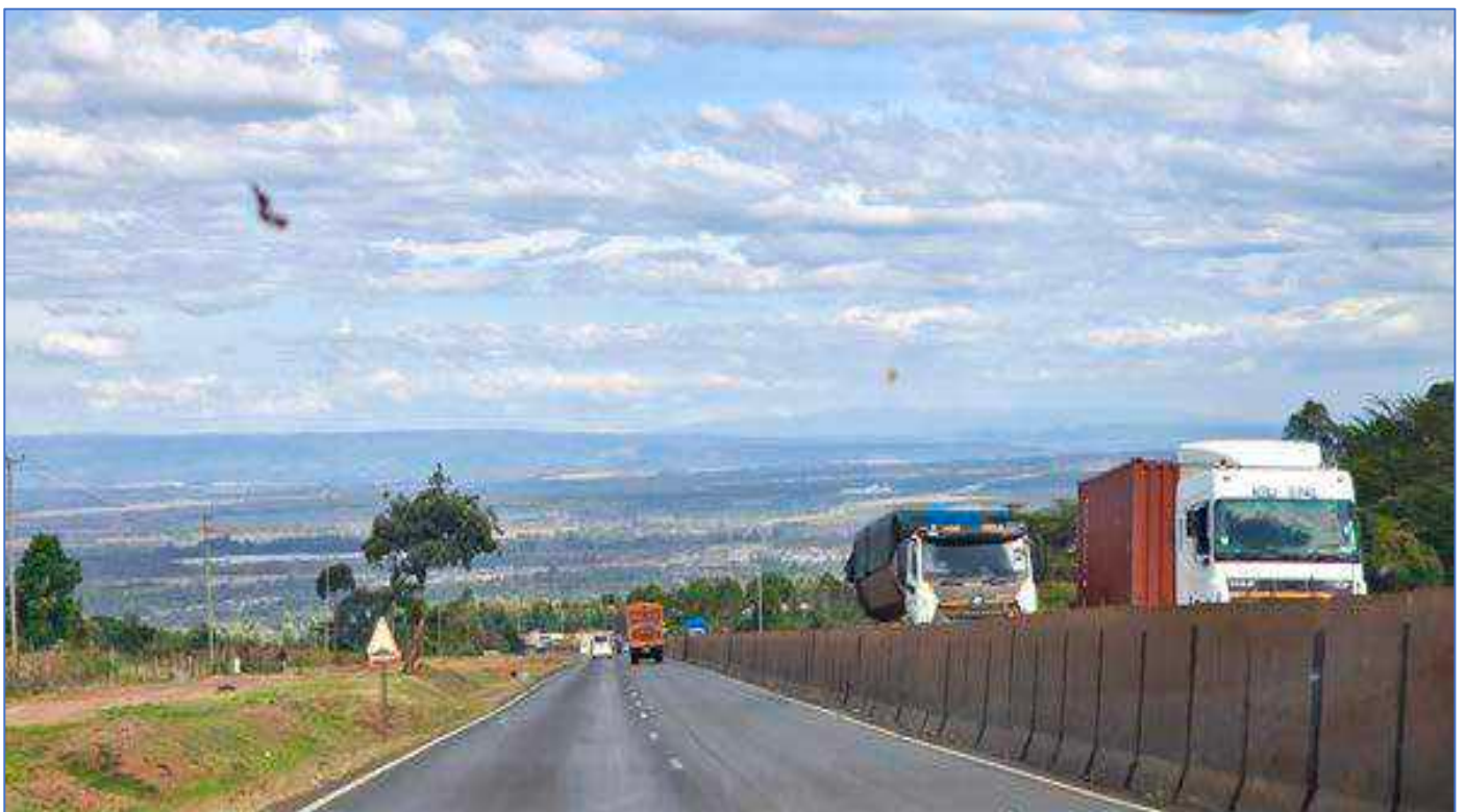
De afdaling naar Nakuru in de Rift Valley is hier heel steil. Daarom zijn er stevige afscheidingen geplaatst om roekeloos, ongeduldig inhalen te voorkomen.
