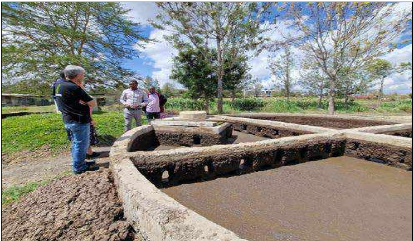
De koeienmest wordt vergist waardoor methaan vrijkomt. Dit levert de energie voor boerderij en weeshuis.
