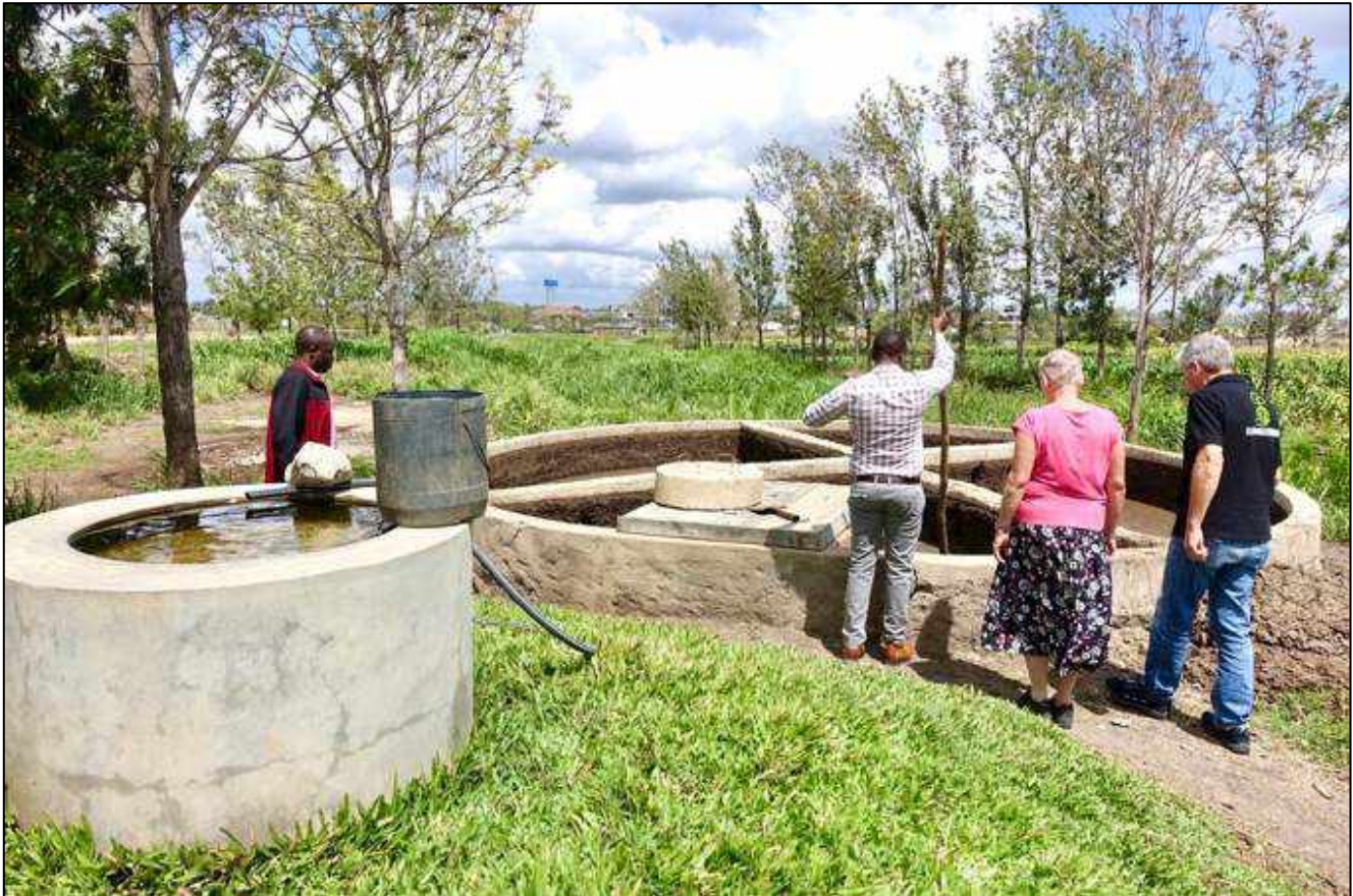
De koeienmest wordt vergist waardoor methaan vrijkomt. Dit levert de energie voor boerderij en weeshuis.
